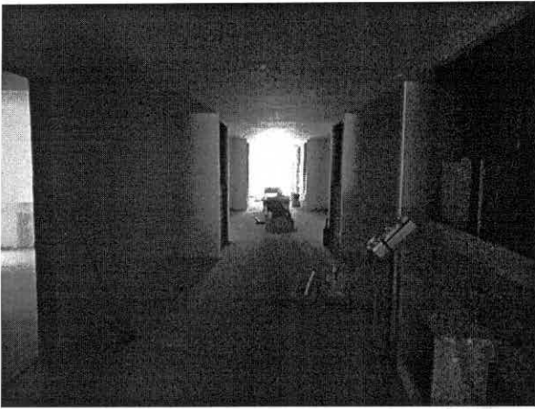
Circulação subtelhado Bloco D
